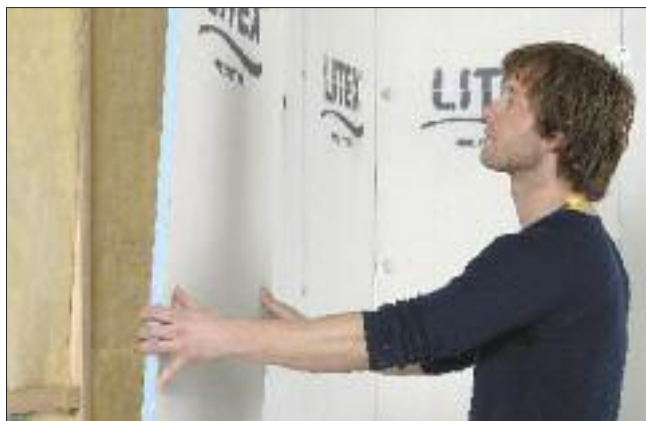
Enkel att montera och fidsbesparande eftersom skivan redan är komplett med tätskikt – glöm bara inte att tätta skarvarna.
